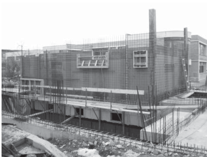
Gradnja crkve sv. Franje Asiškog u sarjevskom naselju Dobrinja
